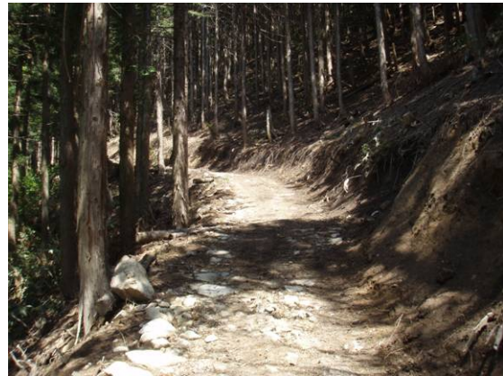
新設した作業道
